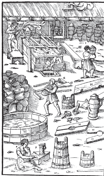
Salzgewinnung durch Eindampfen von Sole in offenen Pfannen
