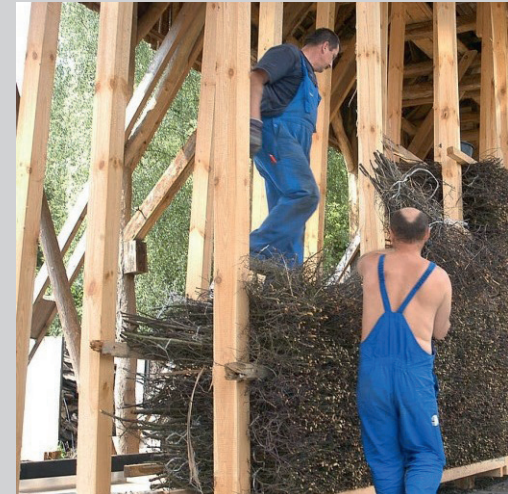
Restaurierung der Gradierwerke
