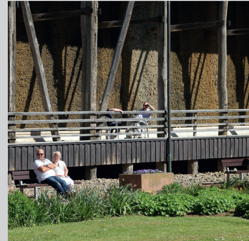
Gradierwerk im Kurpark
